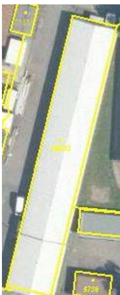
Objekt materiálně technického zabezpečení – 5
