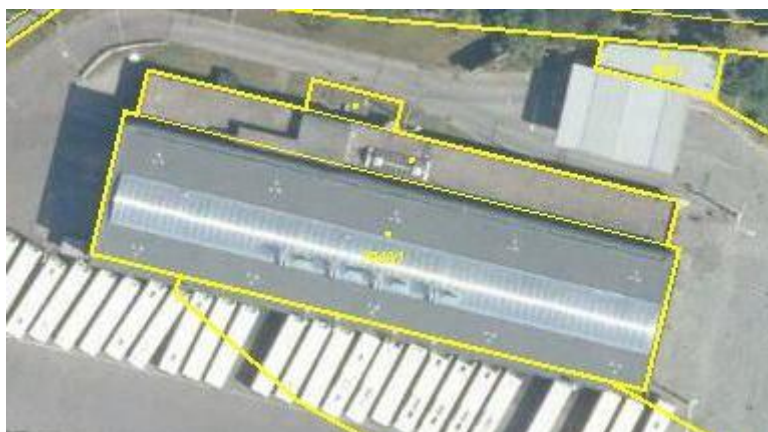
Hala povrchových úprav – 3
